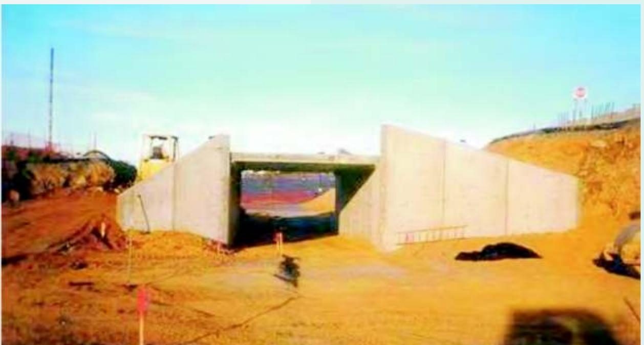
foto ilustrasi: box culvert untuk under pass/Sumber: Istimewa
