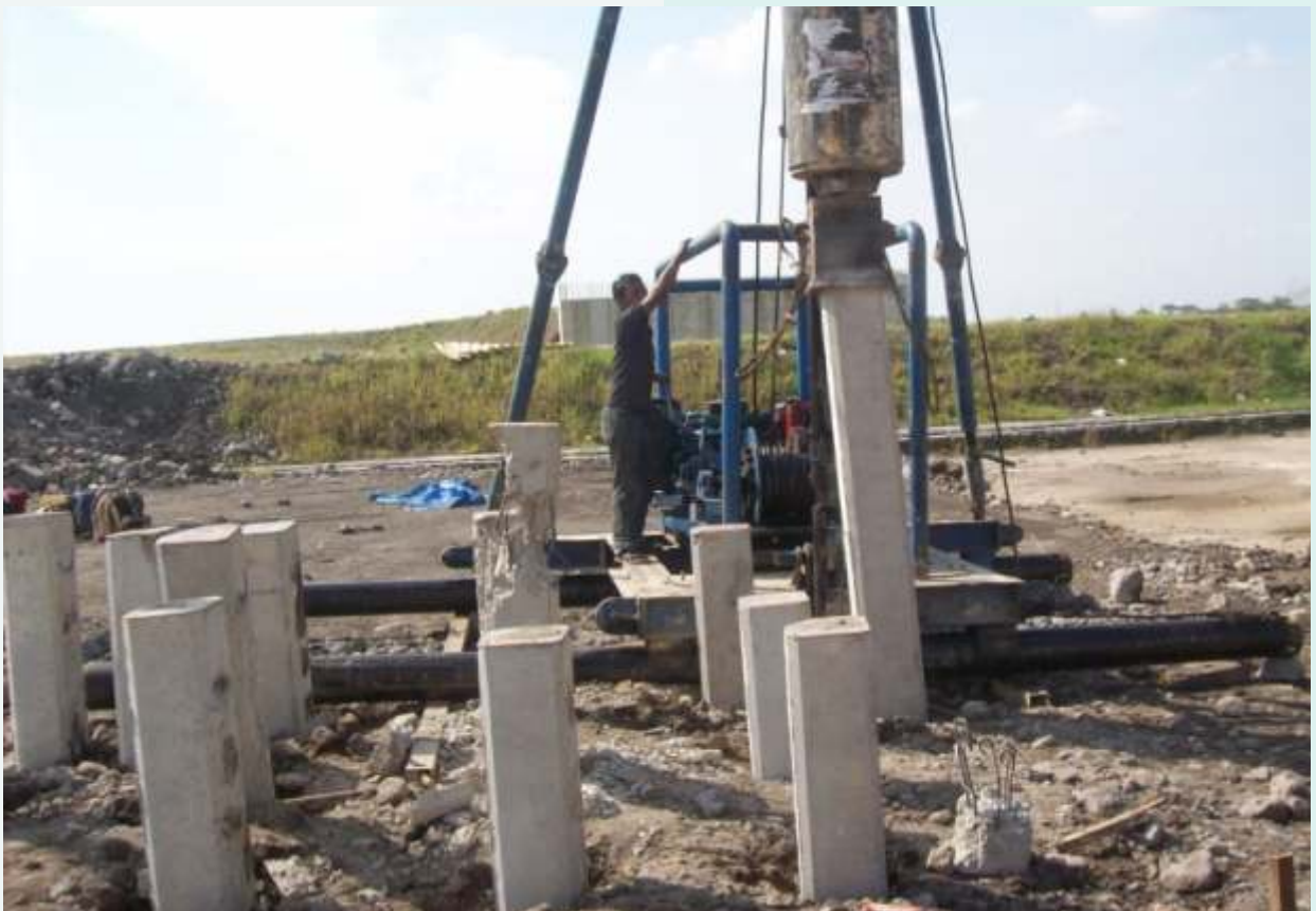
foto ilustrasi : proses pemancangan/Sumber:INTICON
